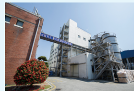
1969 화학 사업 진출 전주 폴리에스테르 공장 준공
